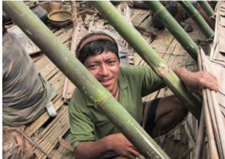
Der Vater einer Foto-Schülerin hilft beim Bau eines Hausdachs im bhutanischen Dorf Kagtong. Die Bambusdächer, gedeckt mit getrockneten Bananenblättern, verschwinden dort zunehmend. Wellblech ist beliebter, weil es länger hält. Das Bild unten machte Ugyen Dema, 12 Jahre alt. Das Bild links stammt von Markus Wild.
